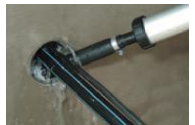
... Kabeldurchführung wird mit ...
