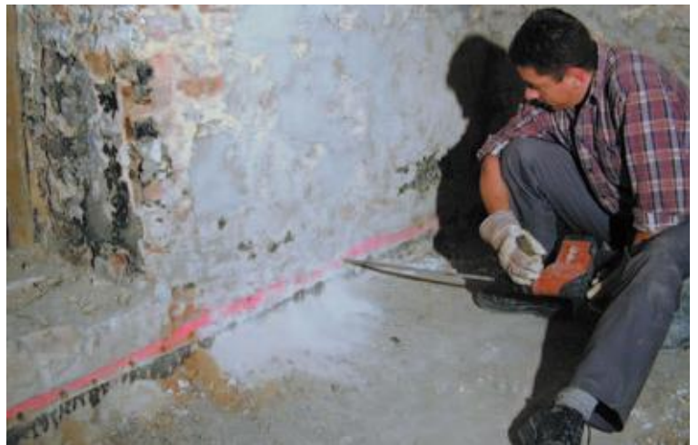
Nachdem der Putz abgeschlagen wurde, konnte mit den Bohrungen entlang der Markierungslinie begonnen werden. Ein besonderer Vorteil bei der großen Bohrtiefe und der hohen Anzahl an Bohrlöchern: Es kann horizontal gebohrt werden.
